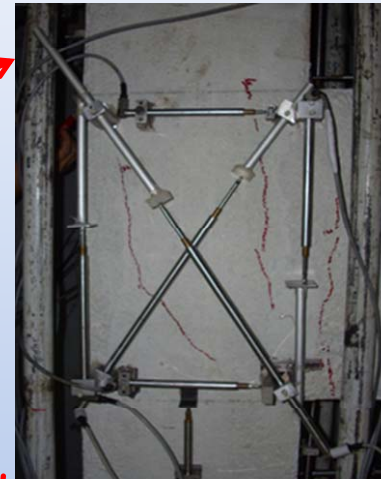
3° Ciclo Prima fessurazione ( Drift =0.52%, V_c = 33.2 kN)
