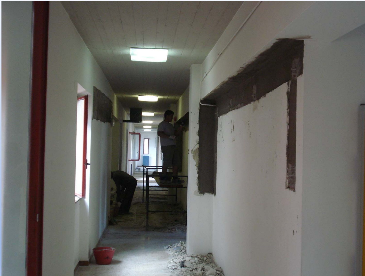
Istituto Tecnico Commerciale: interventi di collegamento perimetrale
