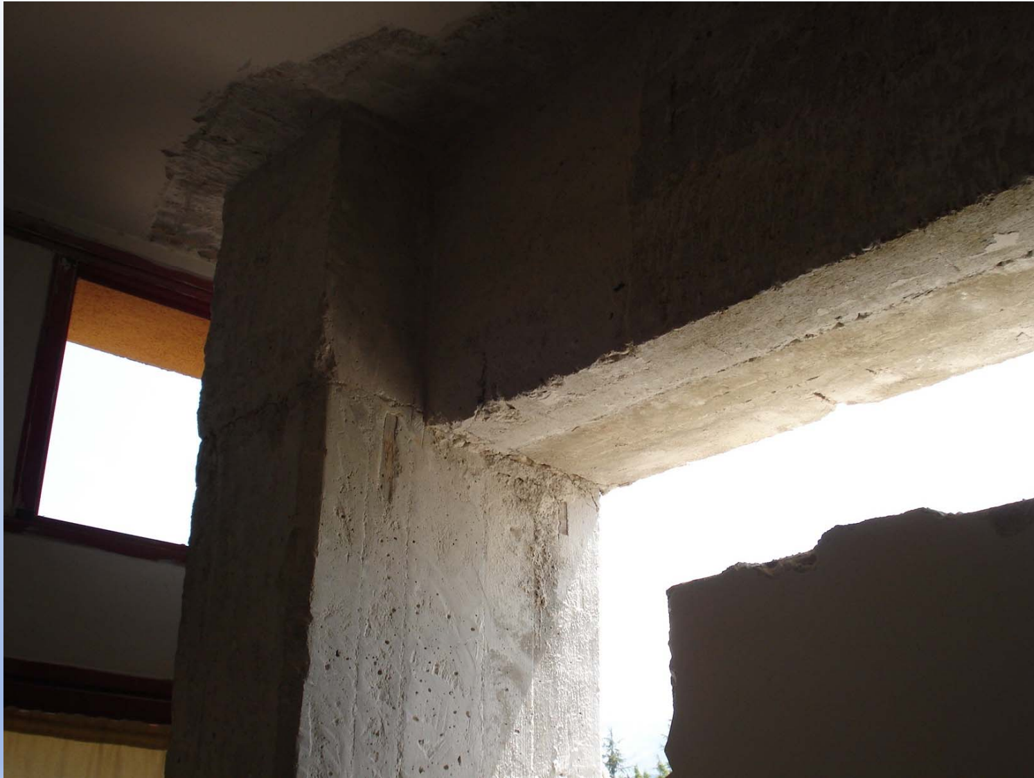
Scuola media Dante Alighieri: fasi di preparazione intervento nodi
