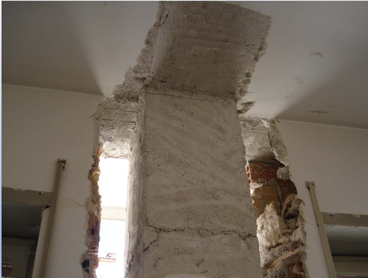
Scuola elementare a Paganica: fasi di preparazione intervento nodi
